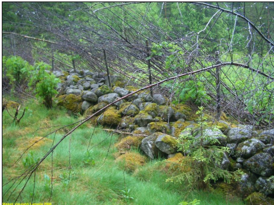
Kiviaitaa voimajohtolinjan alla – vesakkoa kaadettu päälle.
